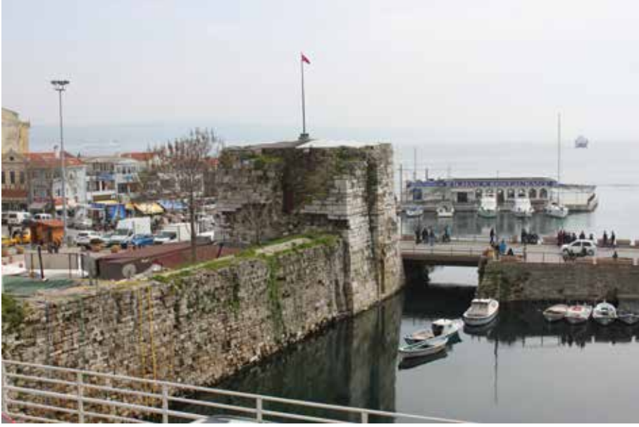
Resim 1. Gelibolu Kalesi limanı ve kulesi, kuzey cephe, 2013.
