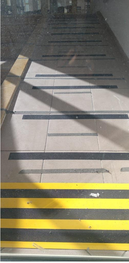
KANTİN GİRİŞ RAMPASI
