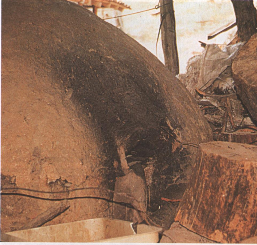
Resim 14- Fırın baca çekişi yandan verilen bir açıklıktan sağlanmaktadır.
