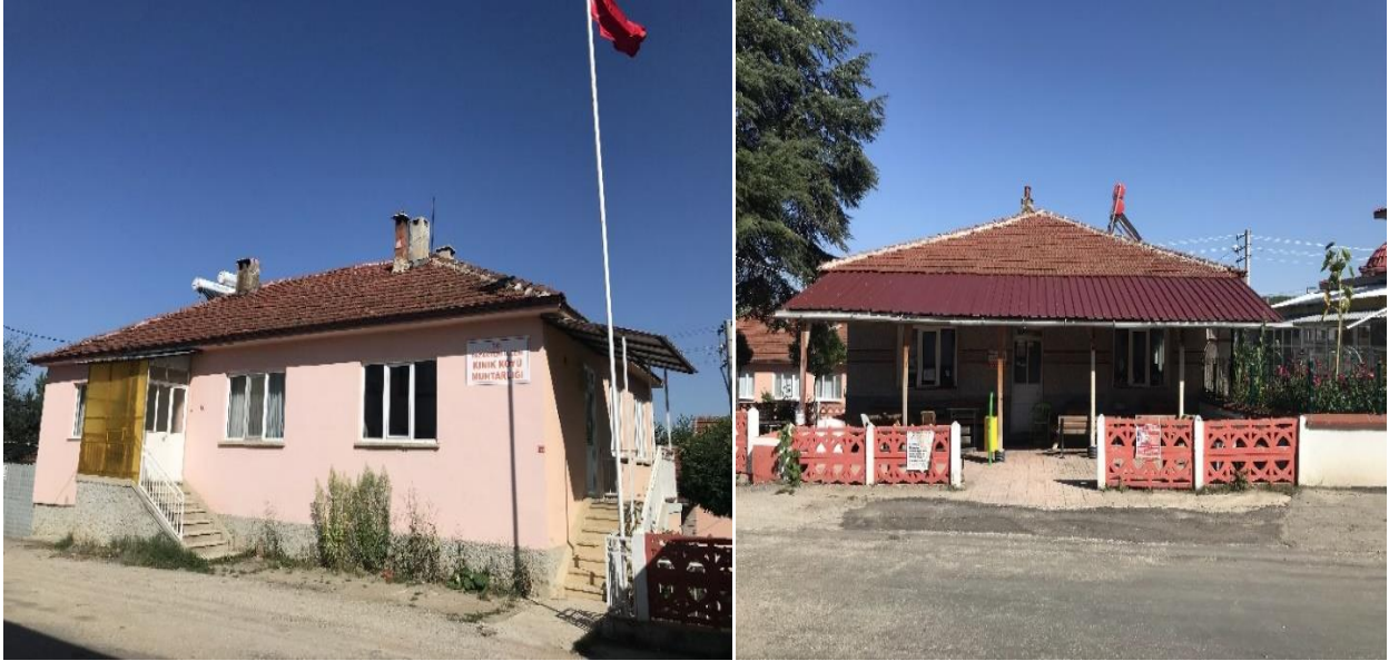
FOTOĞRAF 9- Kınık Köyü Muhtarlık binası (solda) ve Köy Kahvehanesi (sağda) EKİM 2022 - Necmi TEKİN arşivi
