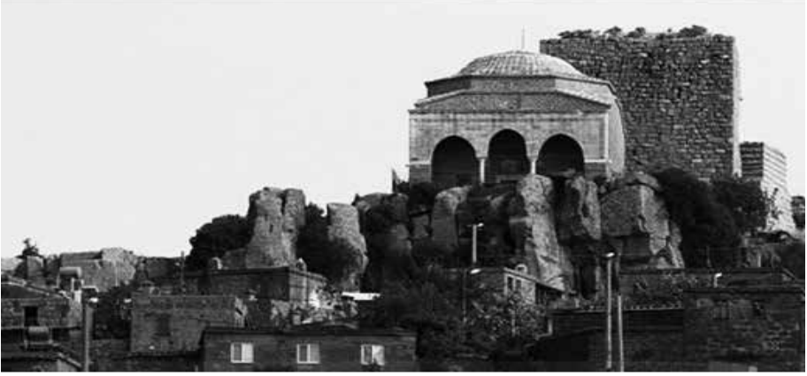
Res.1. Behramkale, Hüdavendigâr Camii, kuzey cephe
