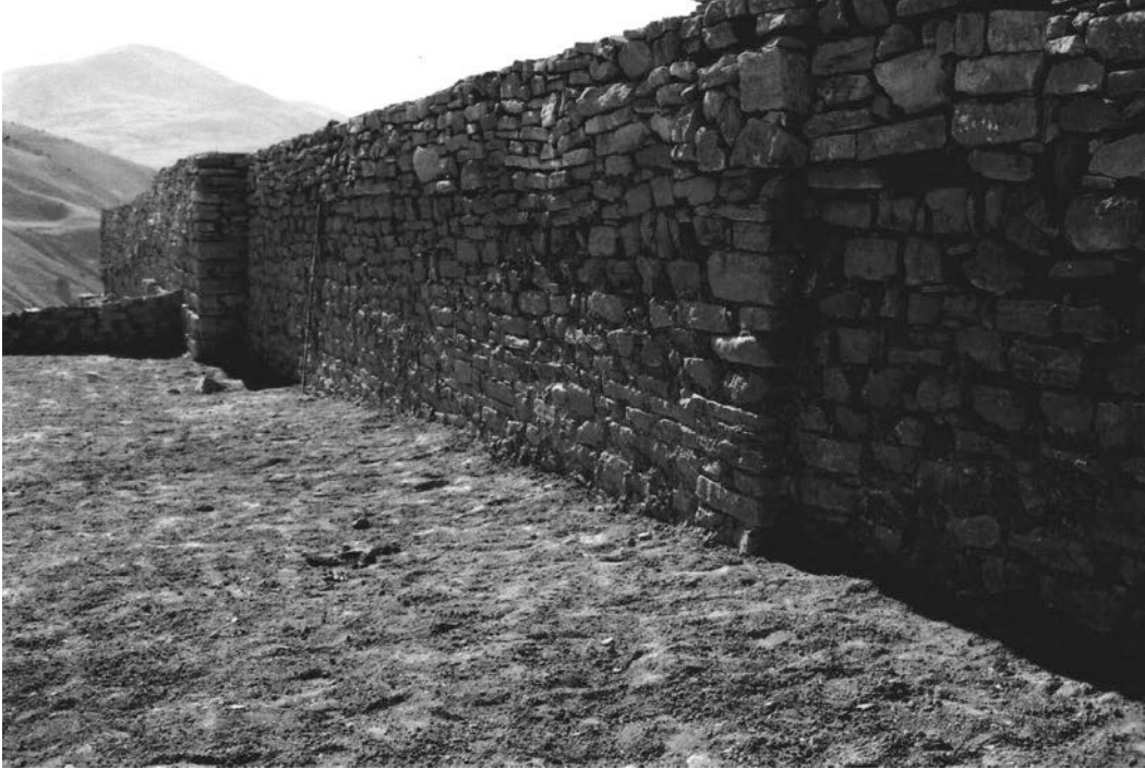
Res. 4. Sarayın batı bölümündeki yapıların yüksek duvar kalıntıları, kuzeyden bir görüntü
