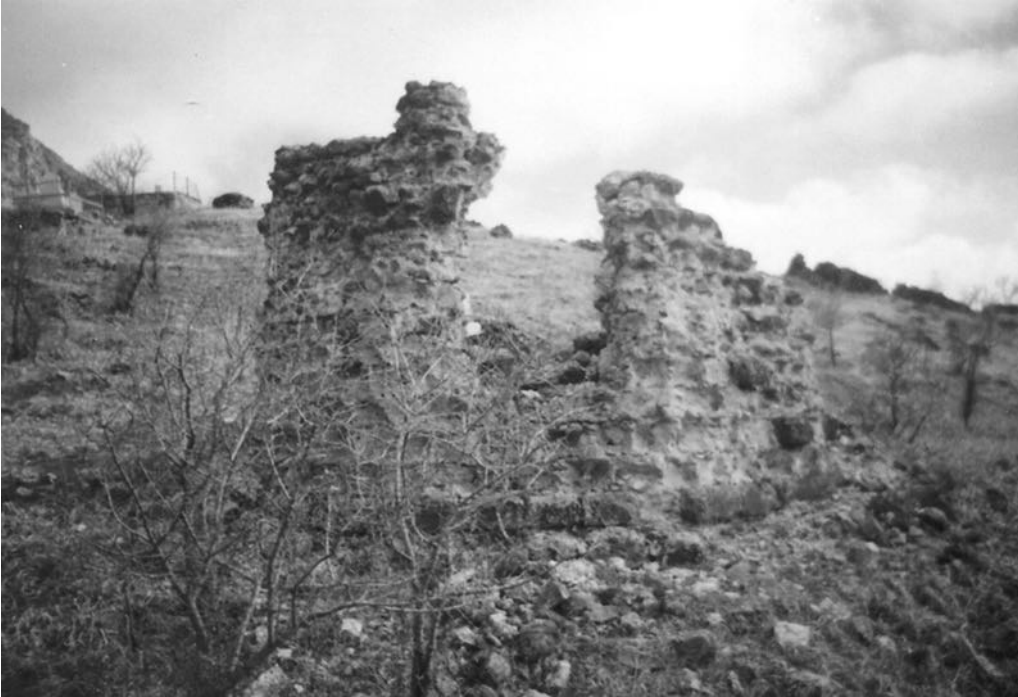
Res. 12. Çoban Dede (Baba) Türbesinin batı cephesi
