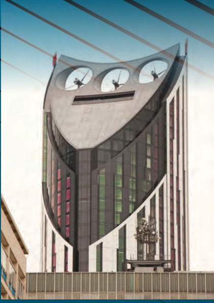
Londra'daki Strata isimli bina, rüzgâr türbinlerinin binanın dokusuna entegre edildiği ilk bina. Bina, enerji ihtiyacının %8'ini üreten üç adet 15 MW gücünde türbine sahiptir.
