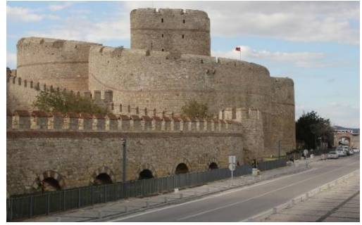
Görsel 12.3. Kilitbahir Kalesi ön cephesi, Namazgah Tabyasının köşesinden bakış, Ekim 2022. (Kaynak: Fotoğraf, Gökhan Keleş)
