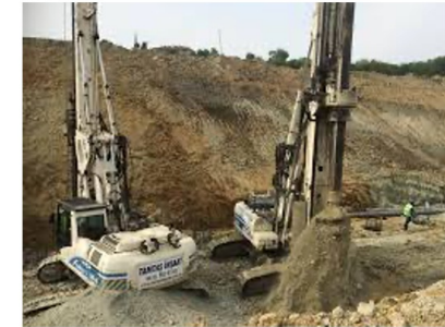
Şekil 2. Fore kazık uygulaması.
