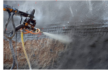
Şekil 1. Shotcrete uygulaması.
