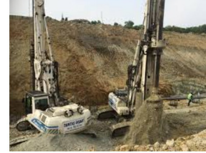
Şekil A. 1. Fore kazık uygulamasında ikinci aşama.
