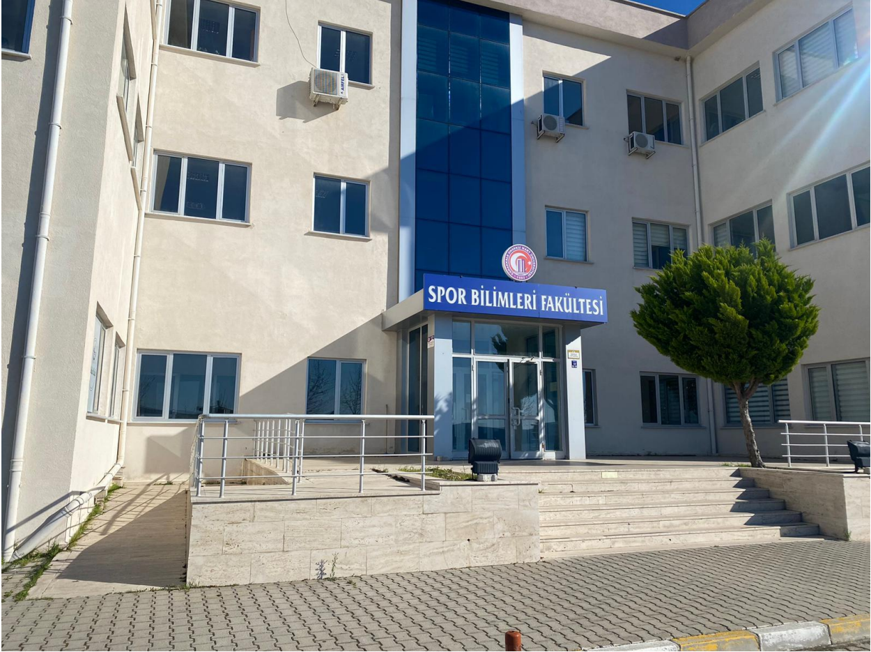
Fotoğraf 6.5.2. Fakülte binası girişi engelli rampası
