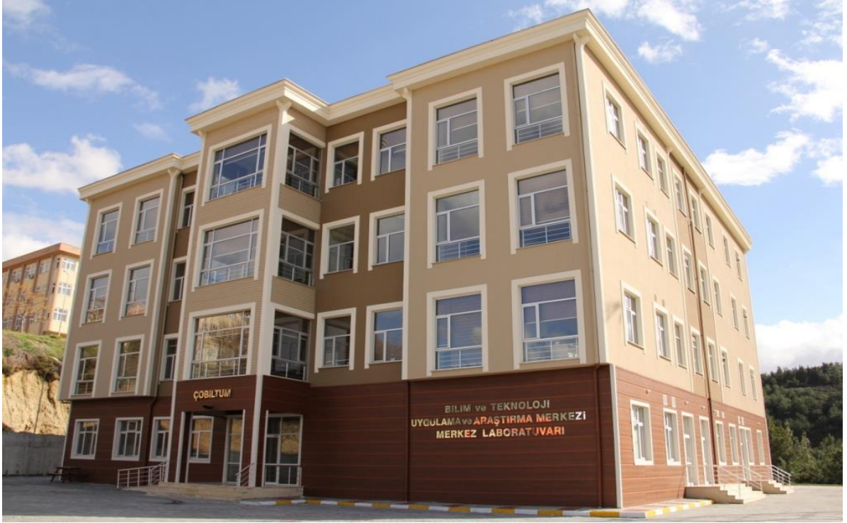
Merkezi Araştırma Laboratuvar Binası
