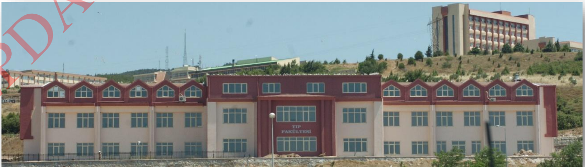
Fotograf 2 Tıp Fakültesi Dekanlık Binası, 2007-2019
