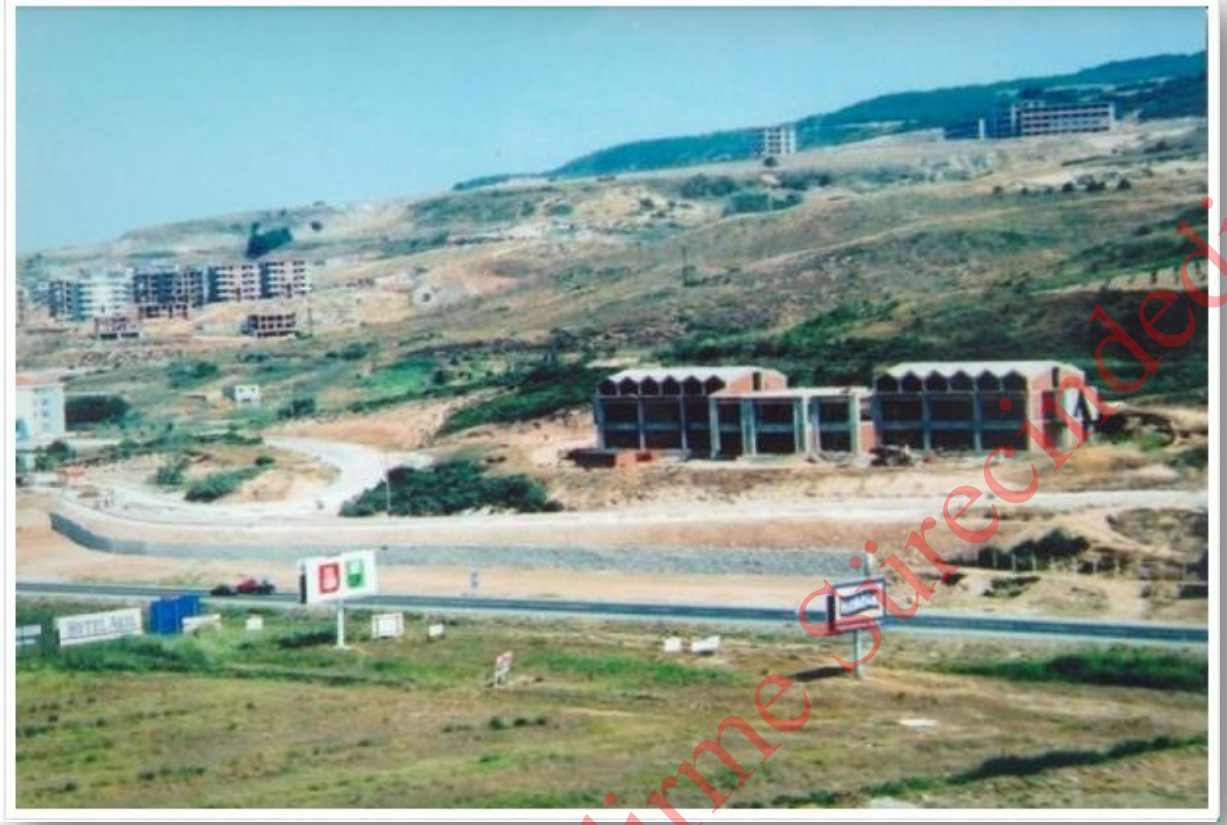
Fotograf 1 Tıp Fakültesi Bina İnşaatı
