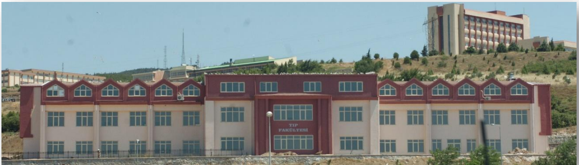
Fotograf 2 Tıp Fakültesi Dekanlık Binası, 2007-2019
