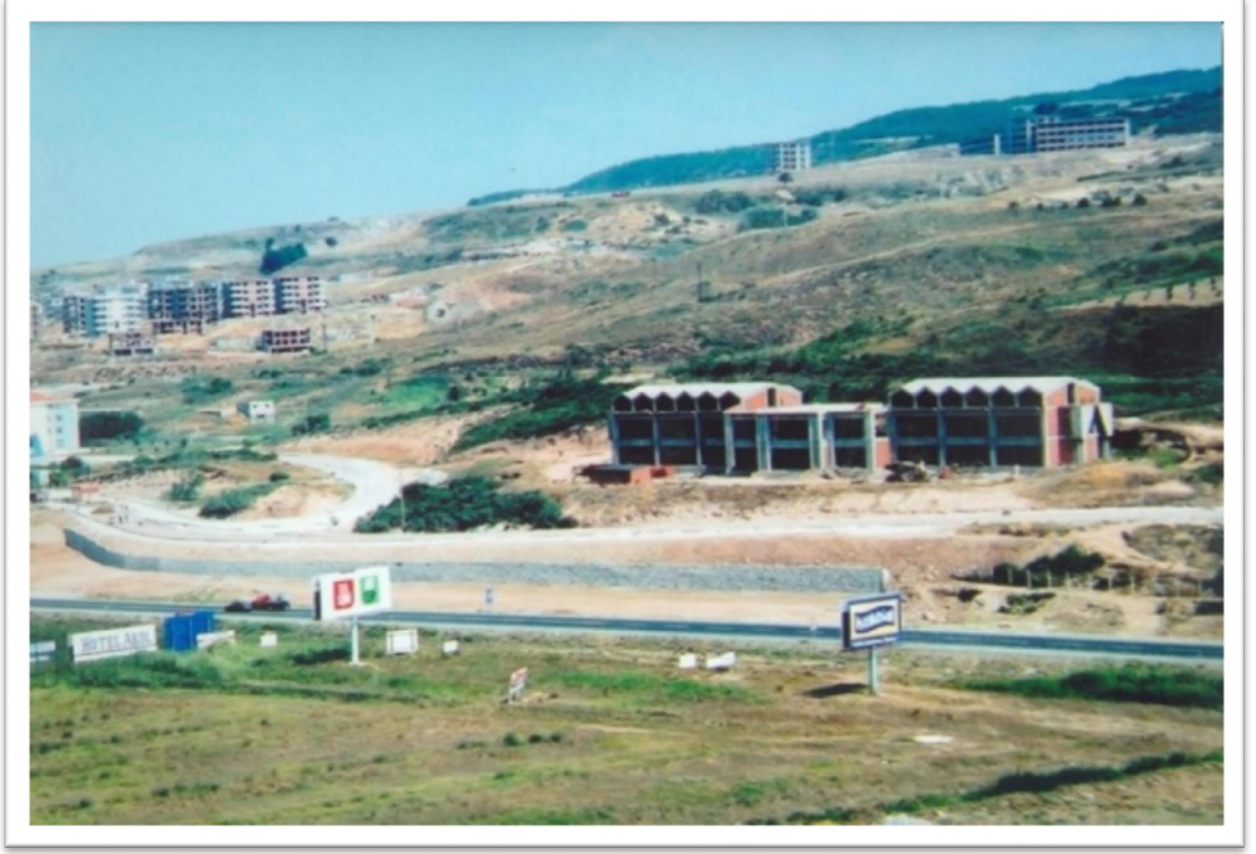
Fotoğraf 1 Tıp Fakültesi Bina İnşaatı
