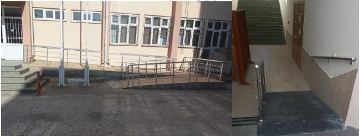
Şekil 39. Ziraat Fakültesi Engelli Rampası
