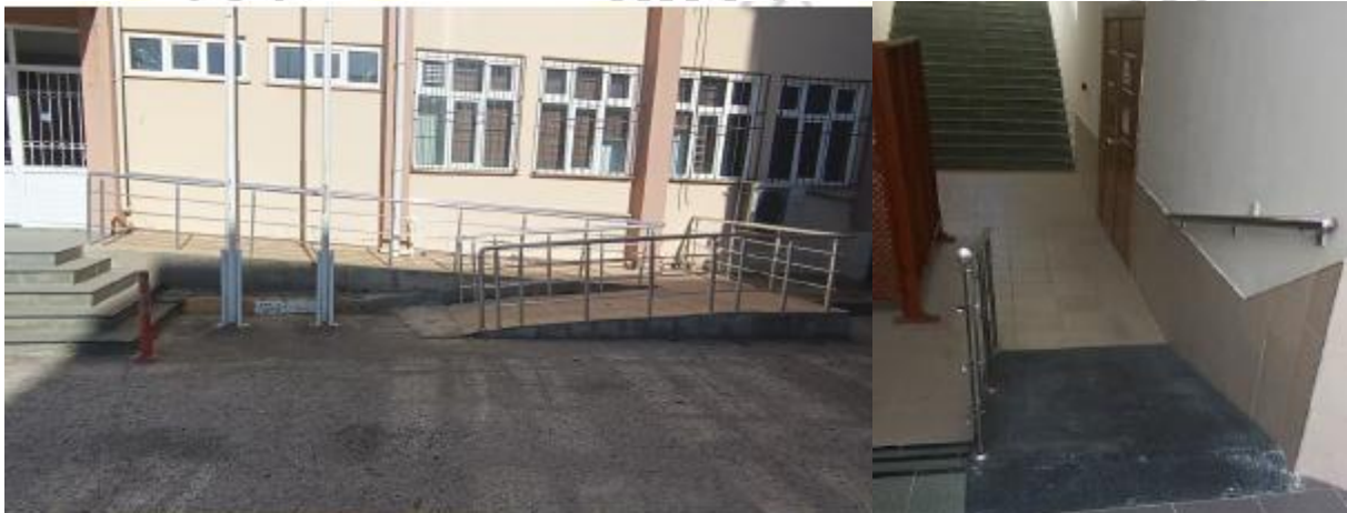
Şekil 39. Ziraat Fakültesi Engelli Rampası
