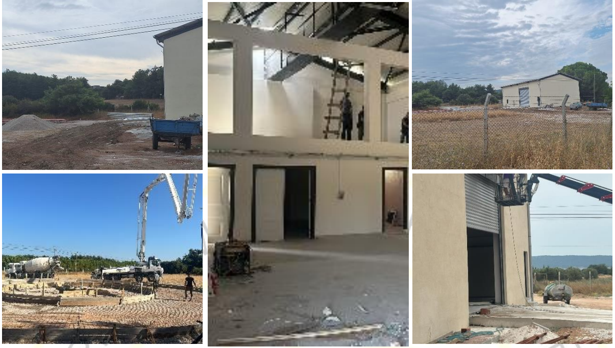
Şekil 27. Yapım aşamasındaki yeni Atölye ve tarım makineleri deney altyapısı
