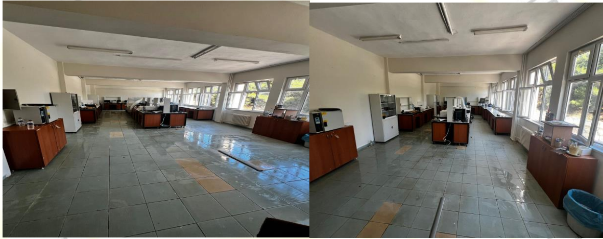
Şekil 22. Öğrenci laboratuvarının bakım onarımının yapılması
